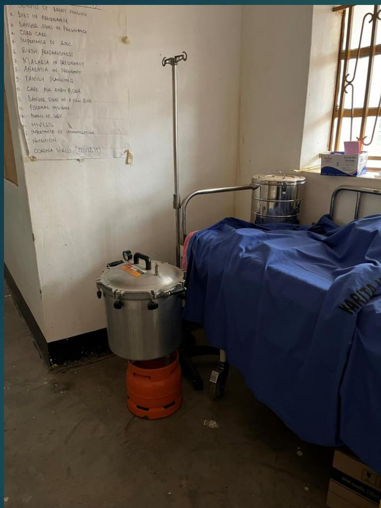
Der Autoklav wird aus einer Gasflasche betrieben, was auch eine erhebliche Explosionsgefahr bedeutet.
